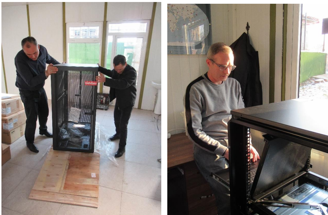
Рис. 1. Работы по установке СНП.
